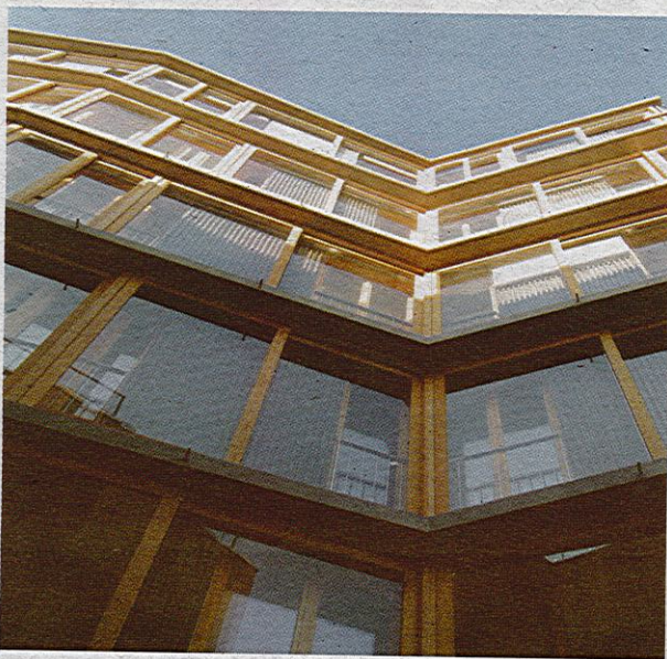
Rue des Orteaux, à Paris, les façades, deux parois vitrées coulissantes, créent des loggias étroites, non chauffées, telles des microserres.
